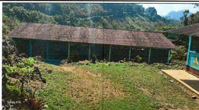
Foto 2: La estructura del establecimiento requiere mantenimiento y cambio de techo.
