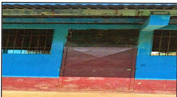
Foto 3: El techo del establecimiento tiene filtración de agua por lo tanto requiere cambio
