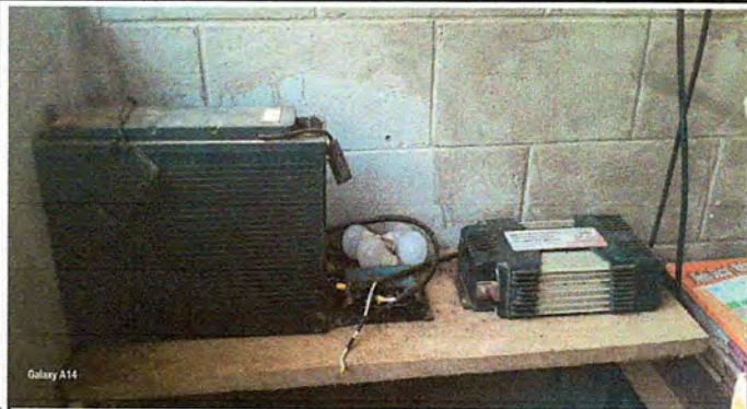
Foto 1: El panel solar se requiere cambio de batería, inversor, cables y bombillas para mejorar las aulas de los estudiantes.
