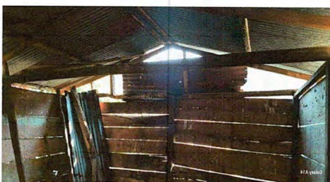
Foto 4: La estructura de la cocina se requiere cambio de techo y costanera.
